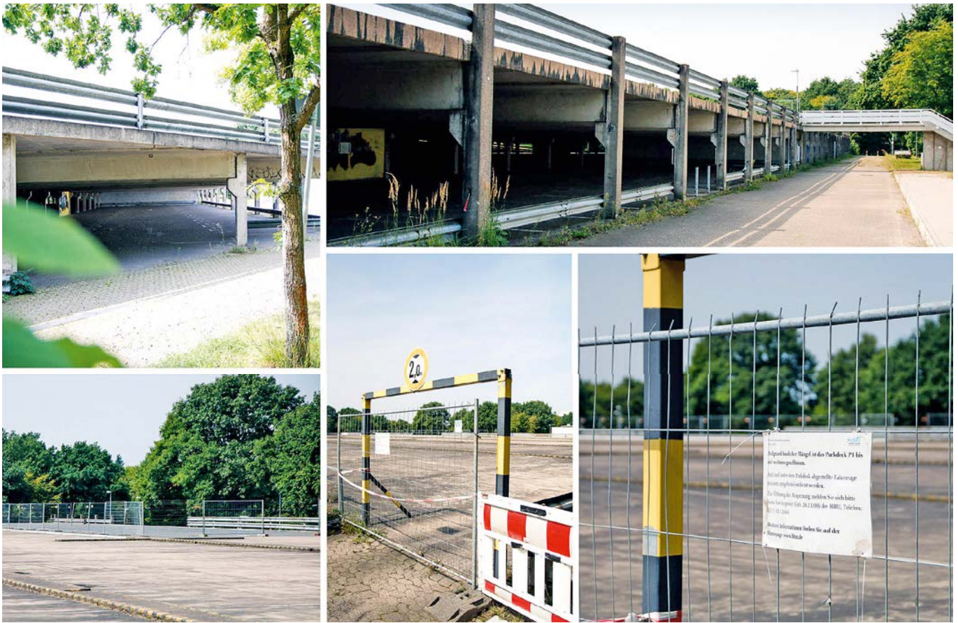
► Auf der Fläche des gesperrten bisherigen Parkdecks P1 (Gebäude 27.02) im Süden des Campus entstehen bis November 400 Parkplätze. (Fotos: Lukas Piel)
